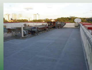
TW-181 PU Hybrid Waterproofing-2 nd Coat
