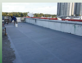
TW-181 PU Hybrid Waterproofing - 1 st
